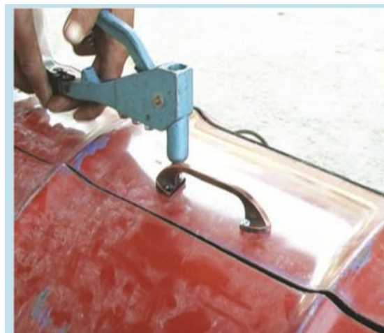
9. ตัดตั้งที่จับสำหรับช่องเปิดปิดเหนือตะแกรงอย่าง
