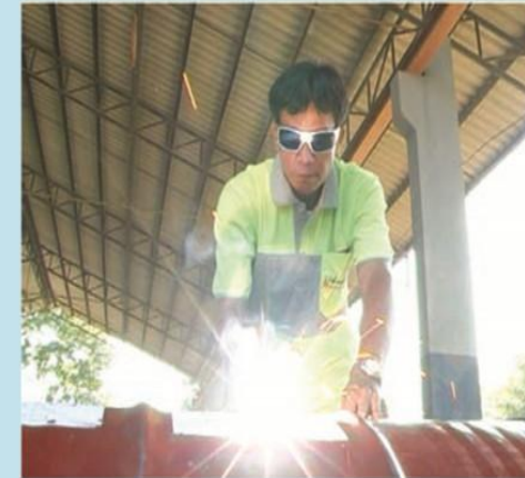
20. เชื่อมติดกับท่อเหล็กขนาดเส้นผ่าศูนย์กลาง 2 นิ้ว ความยาว 10 เซนติเมตร เพื่อเป็นท่อระบายความร้อน
