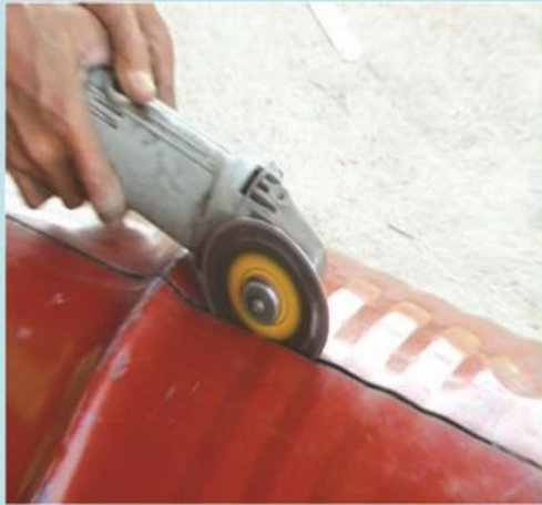
14. ทำการตัดครึ่งถังตามแนวอนด้านหลัง
