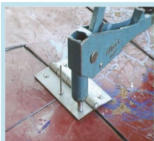
6. ใช้หมุดยึดบานพับของช่องเสียถ้าจำเป็น
