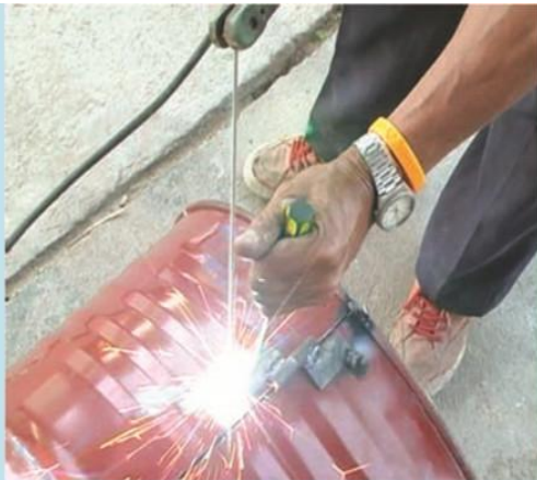
15. ทำการติดตั้งบานพับที่ทำจากเหล็ก โดยเชื่อมยึดติดระหว่าง ฝาครอบ และเตาย่าง
